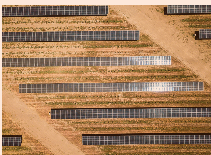
oEnergy cuenta con un pipeline de 43 proyectos (2,9 GW en total) distribuidos en 10 regiones del país.
